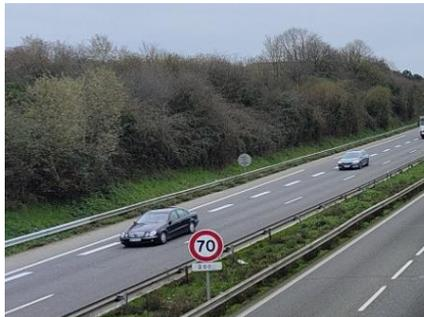
Figure 5 : Terre-plein central sur le tronçon concerné par les travaux : bande enherbée et glissières de sécurité
